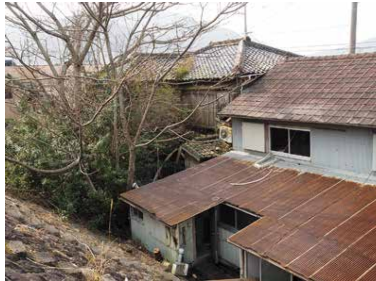
■宿毛市林邸建造物調査 松田川南側堤防に並ぶ古民家 木造二階建て寄棟屋根
