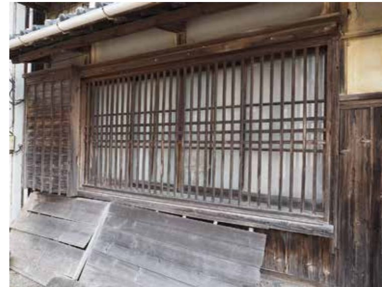
■宿毛市林邸建造物調査 1階部分の古民家格子と戸袋の意匠 真壁で土佐漆喰仕上げ
