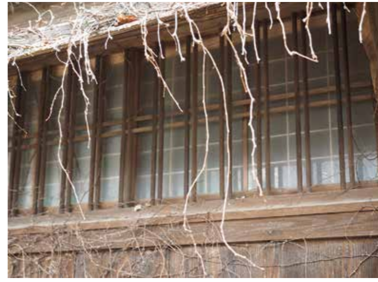
■宿毛市林邸建造物調査 後藤邸主屋南面 開口部の吹き寄せ格子
