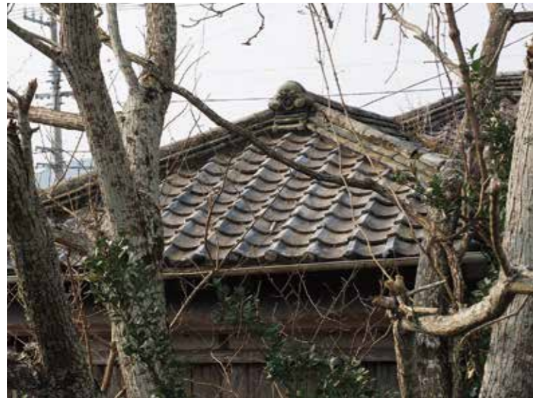
■宿毛市林邸建造物調査 松田川南側堤防に並ぶ古民家 木造二階建て寄棟屋根 右瓦使用
