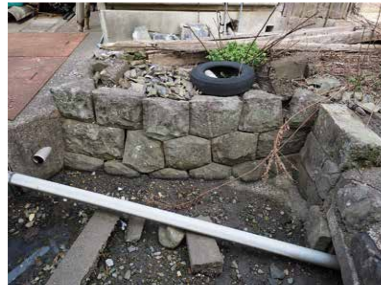
■宿毛市林邸建造物調査 水路沿いの亀甲積み石積み
