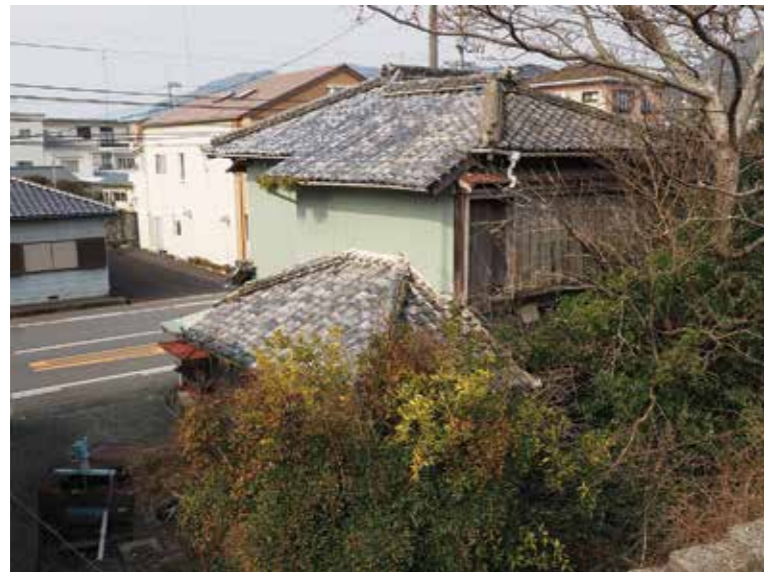
■宿毛市林邸建造物調査 松田川南側堤防に並ぶ古民家 木造二階建て寄棟屋根 付属屋根に寄棟屋根は古い形式
