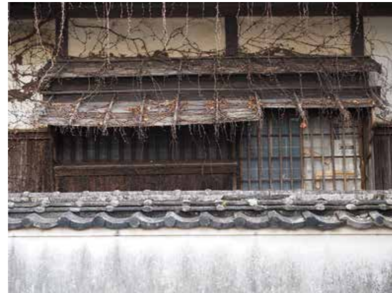
■宿毛市林邸建造物調査 後藤邸主屋南面 二重板庇と木製格子が残る
