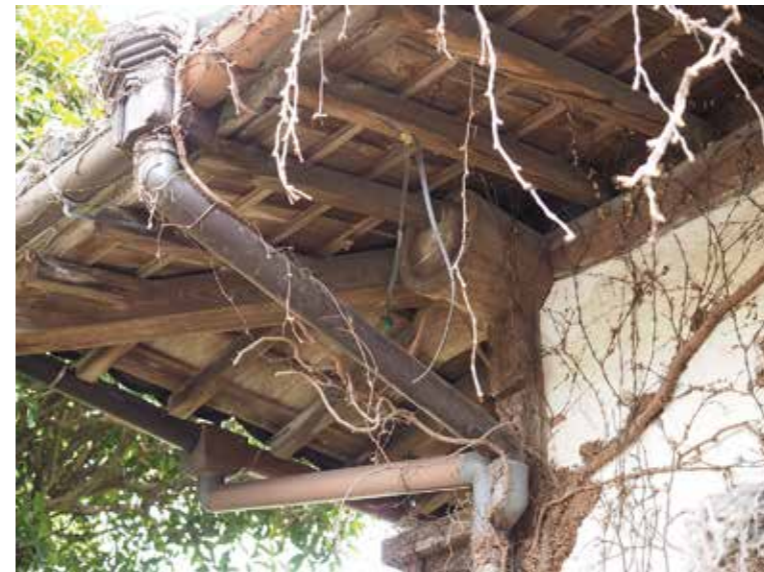
■宿毛市林邸建造物調査 後藤邸主屋南面西隅 軒下部分の丸桁小口 垂木構成 林邸座敷棟で見られるもの
