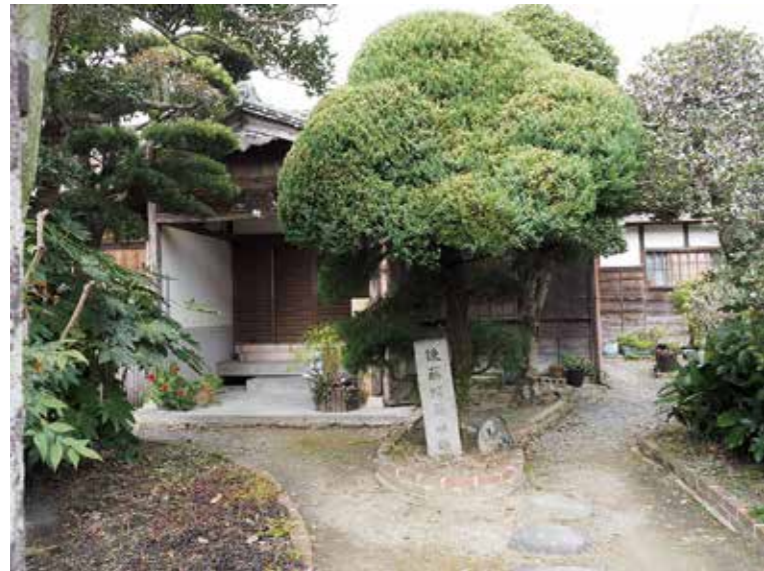
■宿毛市林邸建造物調査 後藤邸正面式台
