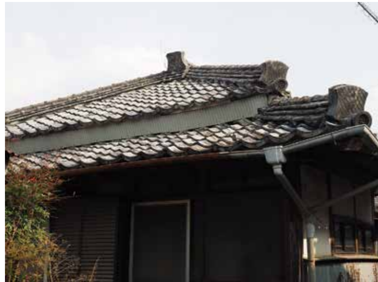
■宿毛市林邸建造物調査 宿毛歴史館北の古民家A南面外観 主屋根の下に下屋が付属
