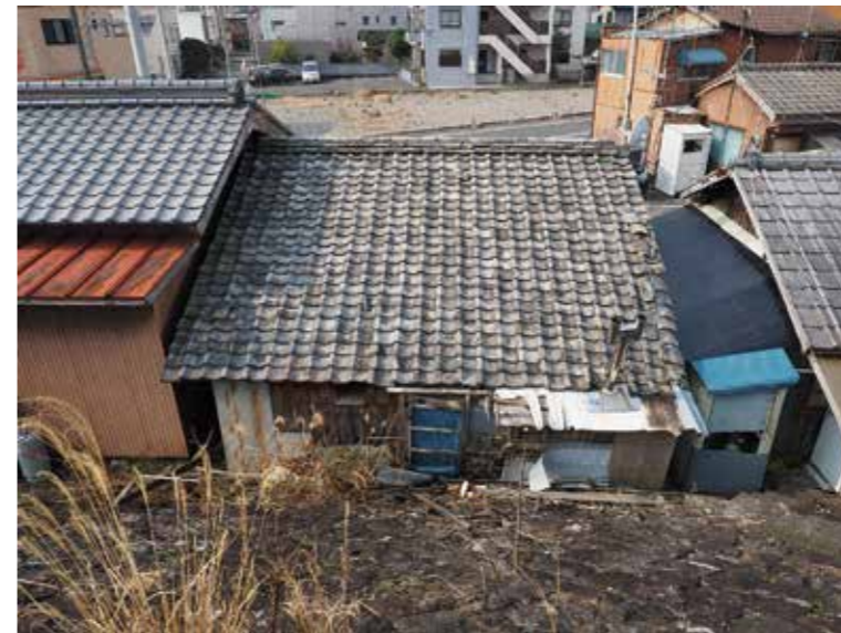
■宿毛市林邸建造物調査 水路沿いに並ぶ古民家の一つ 木造平屋切妻屋根の北面 右瓦使用
