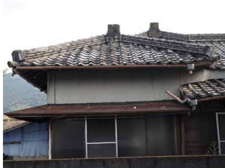
■宿毛市林邸建造物調査 宿毛歴史館北の古民家A南面外観 寄棟屋根で角形の鬼瓦が乗る 右瓦使用
