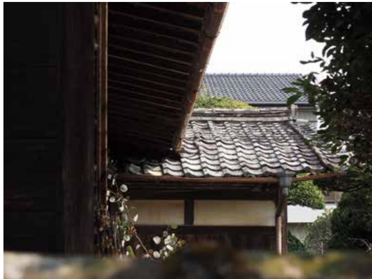
■宿毛市林邸建造物調査 後藤邸主屋正面玄関部分 むくり屋根の構成は林邸と同じ
