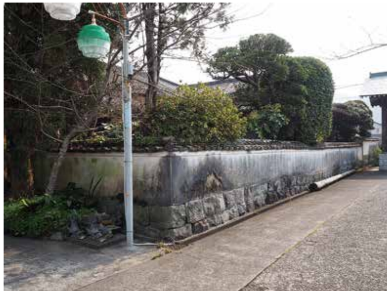
■宿毛市林邸建造物調査 後藤邸敷地南側の築地塀 基礎部分は切石の布積み
