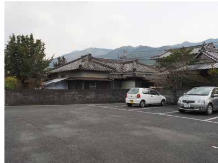
■宿毛市林邸建造物調査 宿毛歴史館北の古民家A南西面外観 寄棟屋根の組み合わせ形式
