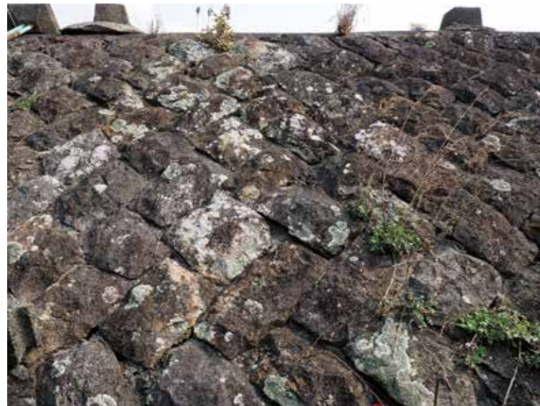
■宿毛市林邸建造物調査 松田川南側堤防南面石積 切石の落とし積み
