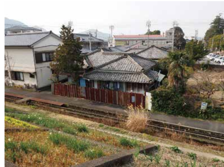
■宿毛市林邸建造物調査 宿毛歴史館北の古民家B北面外観 寄棟屋根に寄棟下屋が付く
