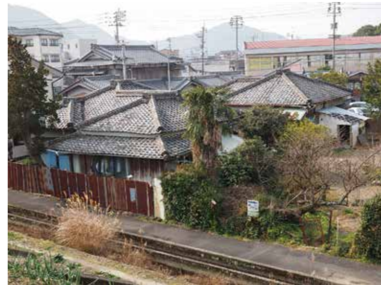
■宿毛市林邸建造物調査 宿毛歴史館北の古民家B北面外観 寄棟屋根の形式の組み合わせ形式
