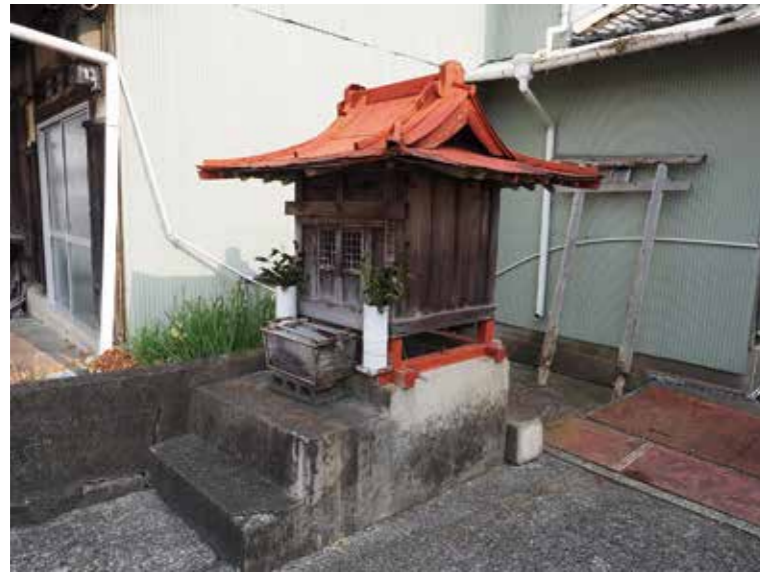
■宿毛市林邸建造物調査 松田川南側堤防に並ぶ古民家横祠 小社だが入母屋屋根形式外観
