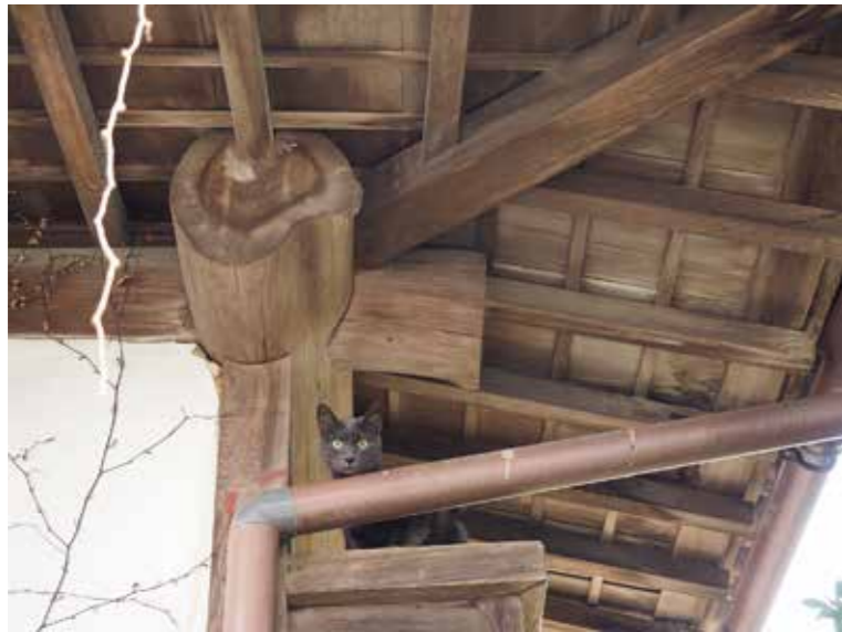
■宿毛市林邸建造物調査 後藤邸主屋南面東隅 軒下部分詳細
