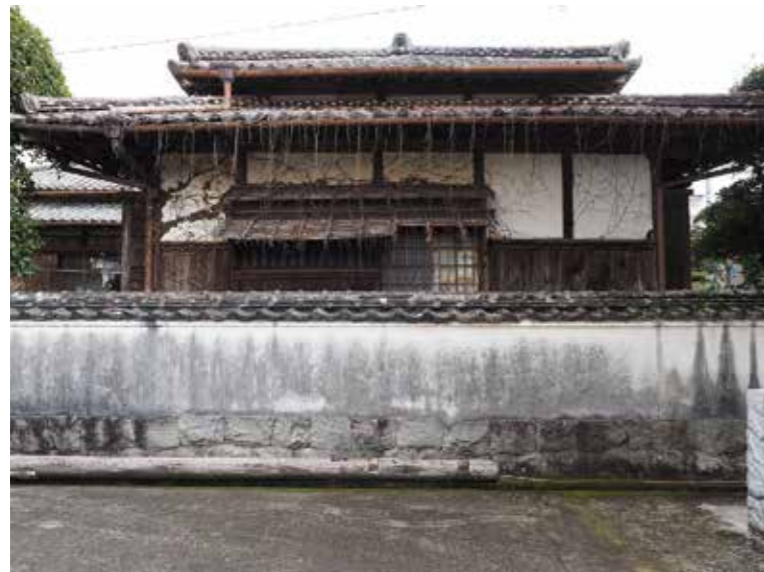
■宿毛市林邸建造物調査 後藤邸主屋南面 寄棟屋根に寄棟下屋付き 古い形式の板庇が残る
