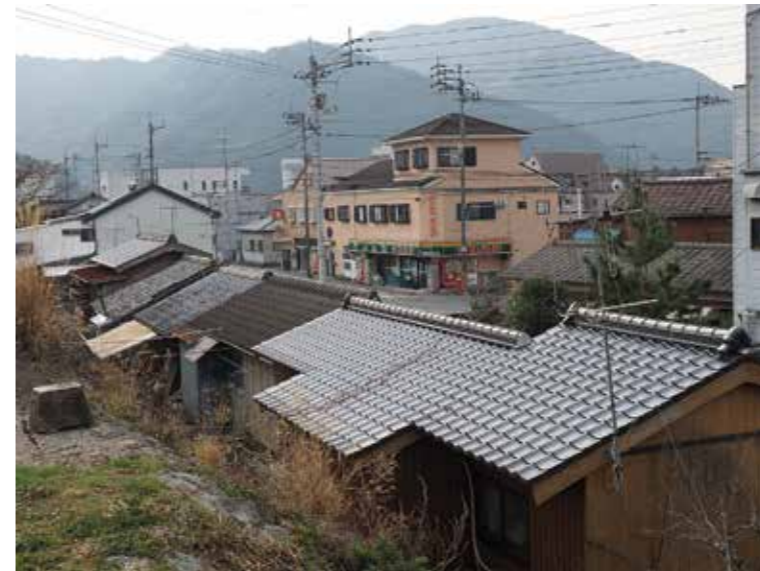
■宿毛市林邸建造物調査 松田川南の堤防沿いに立つ古民家 水路に沿って同じ切妻屋根が並ぶ 木造平屋平入りの形式は古い
