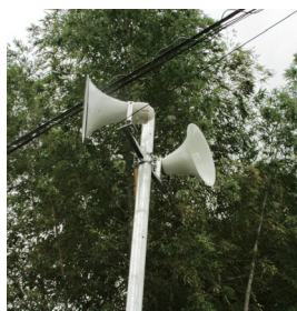
西竹石地区 屋外放送施設整備
