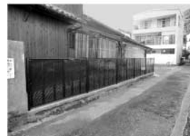
改修後：安全なフェンス
