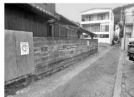
改修前：ブロック塀
