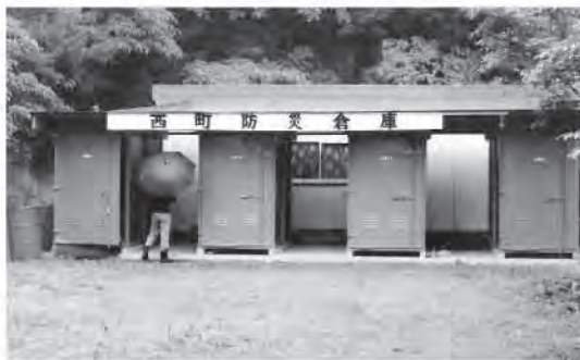
完成した西町地区の防災倉庫
