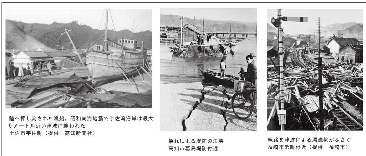
《昭和の南海地震の被害状況》
