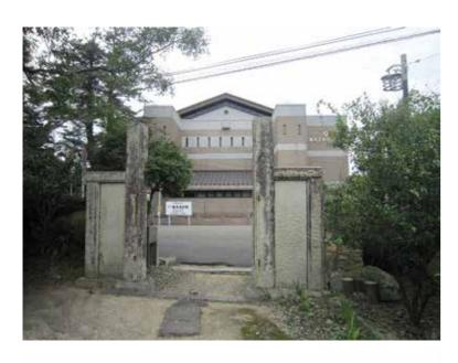
■宿毛市林邸建造物調査 敷地内部から見た門柱 門柱高さ3m、柱径360mm 門幅2380mm、脇柱径270mm 近代初期の門形式が残る
