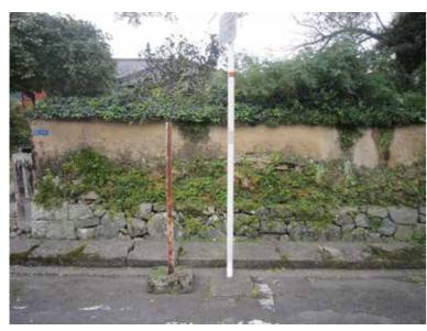
■宿毛市林邸建造物調査 門柱右側の築地塀 基礎部分は角を算木積み 中部分を割石の野面積み 中部分は土壁仕上げ
