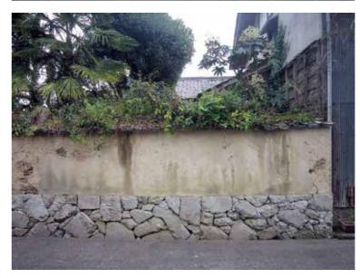
■宿毛市林邸建造物調査 南面 6. 基礎部分に割石積み 塀頂部に瓦屋根
