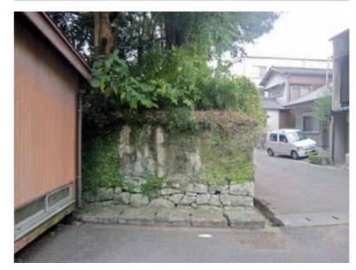
■宿毛市林邸建造物調査 西面南角6. 角部分は切石算木積み 基礎部分は割石の乱積み
