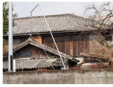
■宿毛市林邸建造物調査 主屋二階北部分寄棟屋根 一階部分切妻屋根の釜屋
