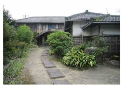
■宿毛市林邸建造物調査 門柱から見た敷地内部の建造物 主屋・客室棟・便所棟 手前から寄棟屋根の形式を順次奥に 構成する
