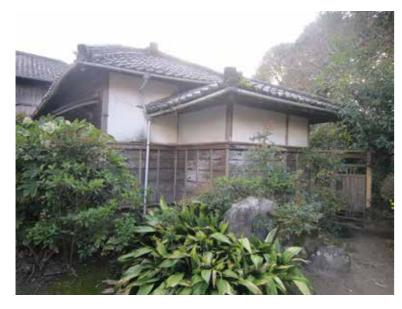
■宿毛市林邸建造物調査 寄せ棟屋根の客室棟と便所棟 腰壁部分は押縁付き下見板張り
