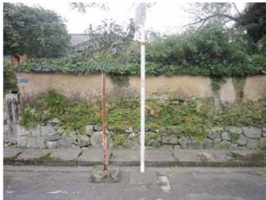
■宿毛市林邸建造物調査 西面2. 角部分は切石の算木積み 基礎部分に割石の乱積み
