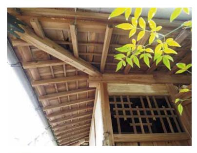
■宿毛市林邸建造物調査 主屋付属の便所棟 軒下部分の換気窓と垂木構成 換気窓の格子欄間
