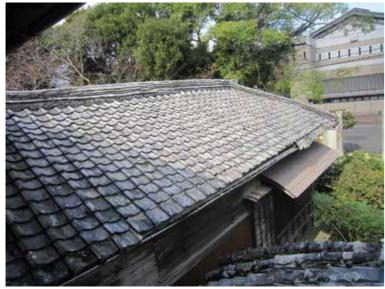
■宿毛市林邸建造物調査 主屋付属の客室棟北面屋根 棟部分は熨斗瓦二枚組 右瓦使用
