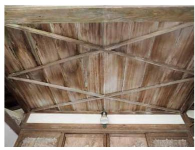
■宿毛市林邸建造物調査 正面玄関天井部分 棹縁を交差させて天井板張り 棹縁を菱型の組み合わせ
