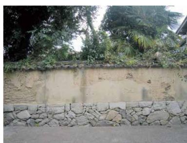
■宿毛市林邸建造物調査 南面 5. 基礎部分に割石積み 塀頂部に右瓦葺き
