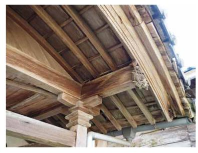
■宿毛市林邸建造物調査 主屋玄関前の蛇腹天井の垂木構成 柱上部のます組構造は社寺的
