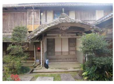
■宿毛市林邸建造物調査 主屋正面玄関部分 破風部分のアーチと円を描くような 起り破風と起り屋根が特徴
