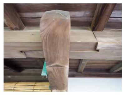
■宿毛市林邸建造物調査一階内玄関外部の軒桁継ぎ手部分追っかけ継ぎ
