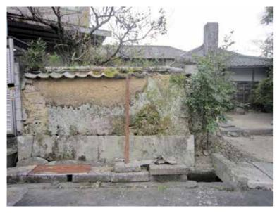
■宿毛市林邸建造物調査 西面 1. 基礎部分に切石積み 土壁部分の内部に古瓦練り積み 塀頂部に雁振瓦・熨斗瓦・桟右瓦
