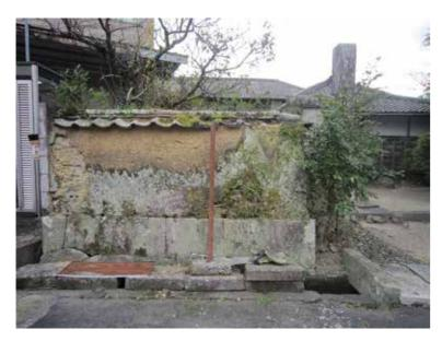
■宿毛市林邸建造物調査 正面門柱左側の築地塀 基礎は切石仕上げ 壁面は瓦練塀に土壁仕上げ 天端瓦は右瓦1枚・熨斗瓦1枚
