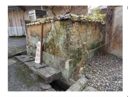
■宿毛市林邸建造物調査 正面門柱左側の築地塀 内部は瓦の練塀で土仕上げ
