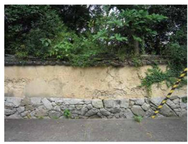
■宿毛市林邸建造物調査 敷地南側築地塀 基礎部分は割石の野面積み 壁面が内部瓦の練り積に土壁仕上げ 塀上部に瓦
