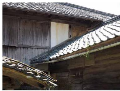
■宿毛市林邸建造物調査 主屋二階西面中央部 付属棟接続部分 真壁の漆喰塗り
