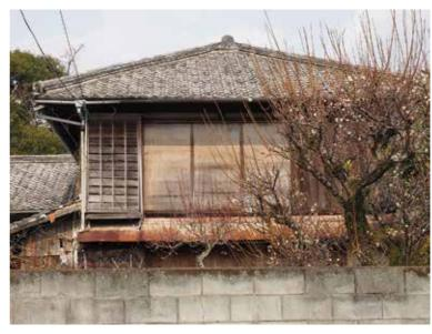
■宿毛市林邸建造物調査 二階東面座敷部外観 屋根は寄棟で桟瓦葺き 1階庇はトタン葺き
