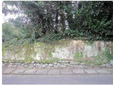
■宿毛市林邸建造物調査 南面 4. 左側に門跡開口部 基礎部分に割石積み 屋根瓦損壊により壁部分に雨だれ痕
