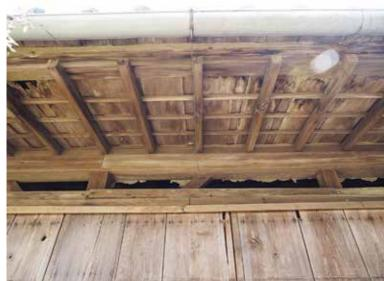
■宿毛市林邸建造物調査 客室棟南面の軒下垂木構成 雨戸上部に換気明かり開口部
