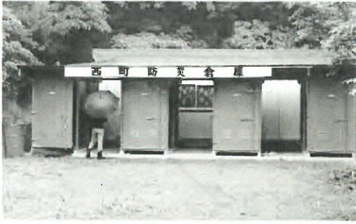
完成した西町地区の防災倉庫
