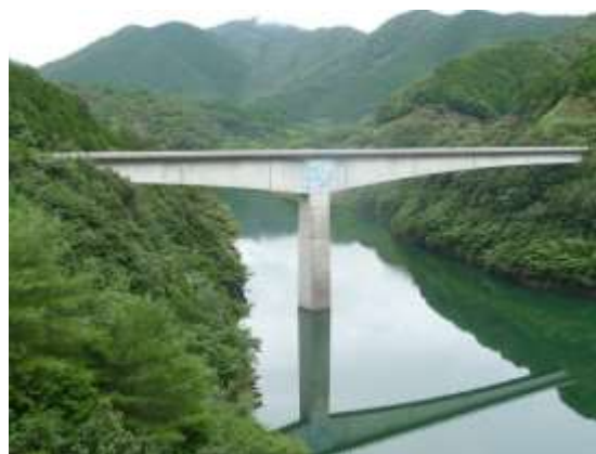
延長の長い橋の事例
