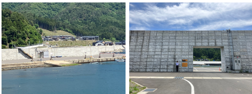
図 L1津波に対応した堤防の整備事例（石巻市雄勝町）
