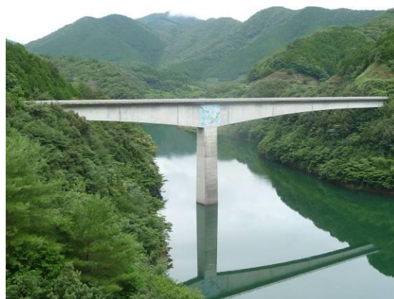
延長の長い橋の事例
