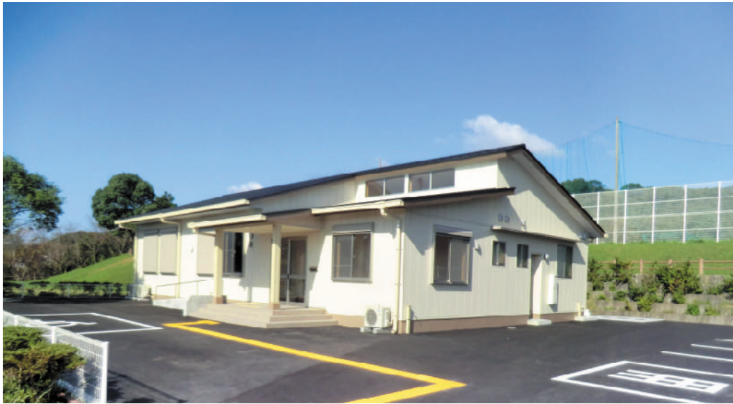
西地区防災コミュニティセンター
