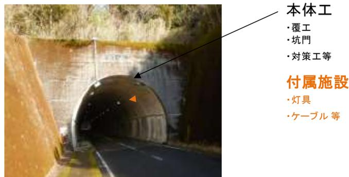
図 1.2 トンネル構造
