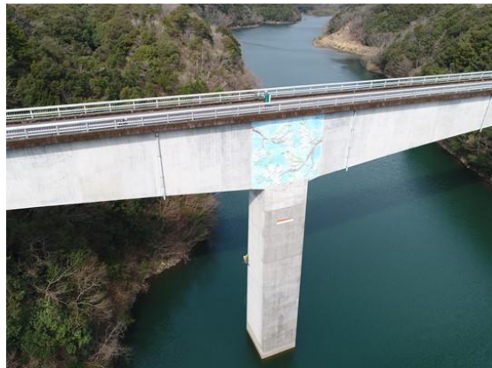
延長の長い橋の事例
