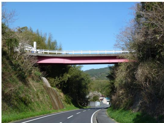
道路を跨ぐ橋の事例
