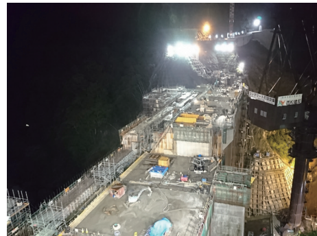
工事中の横瀬川ダム
