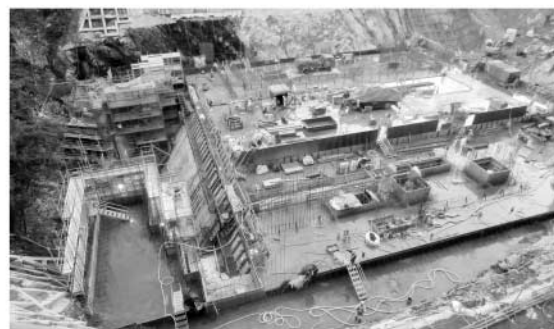
横瀬川ダム建設工事写真
